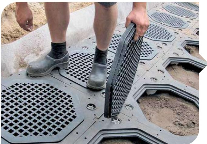
Lorsque tous les éléments sont mis en place, le système peut être fermé. Ce dernier peut également être utilisé sous un revêtement perméable : l'eau de pluie s'infiltré dans le sol à travers les couvercles.
