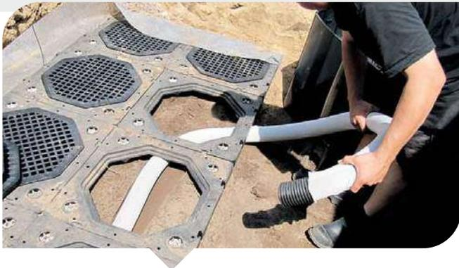
Le système n'est pas rempli entièrement ; une lame d'air d'épaisseur variable est nécessaire pour éviter le soulèvement dû aux racines. La lame d'air est complétée d'un système d'aération/d'irrigation, nécessaire pour l'apport en oxygène et en eau.
