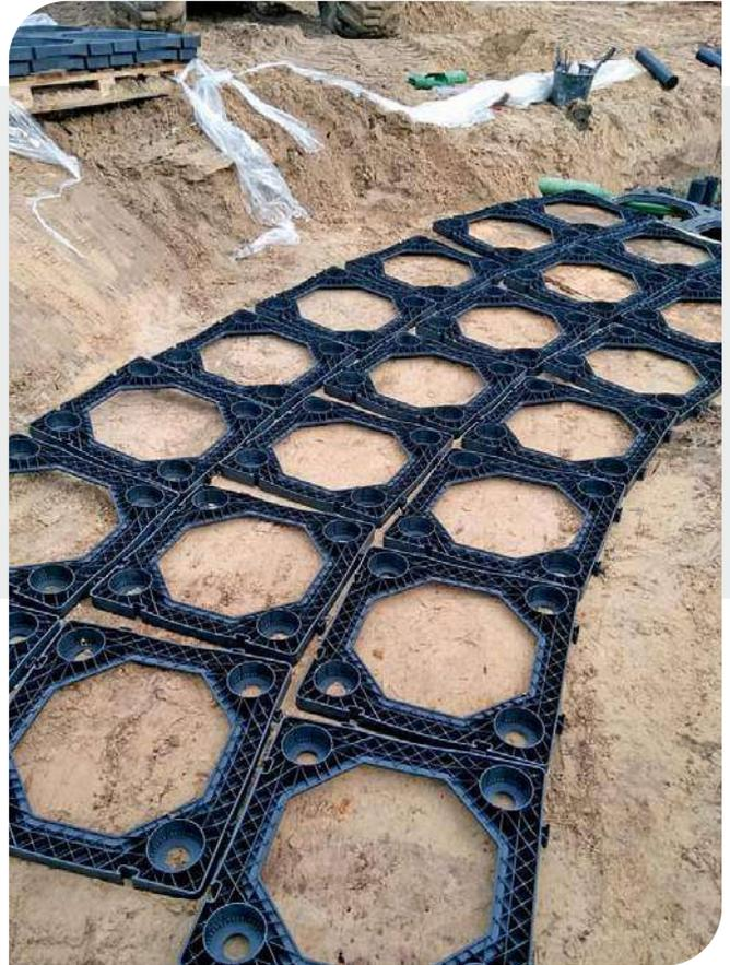
Les cadres sont alors disposés selon le schéma d'agencement. Les modules peuvent être connectés ou non (espacement maximal de 75 mm) ; l'installation peut être faite en courbe ou en quinconce. Dimension utile max. 675 x 675 mm.
