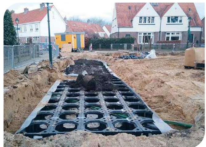
Après la pose de toutes les unités et l'intégration des câbles et des conduits, le système est entouré d'une paroi verticale. Celle-ci est perméable à l'eau et résistante aux racines.
